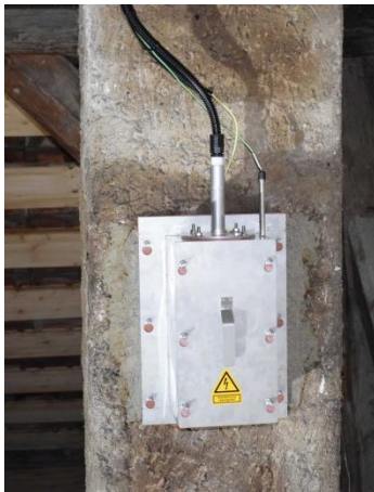
7. Serviceöffnung schliessen und elektrische Verbindung zur Steuerung herstellen.
